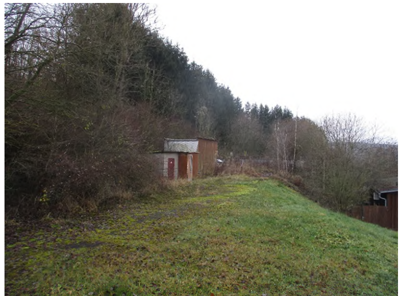
Abbildung 6: schuppenartige, vorhandene Gebäude im Westen des Geltungsbereiches
